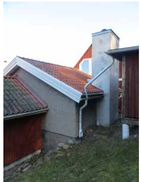
Pannhusets baksida och kraftiga skorsten.
