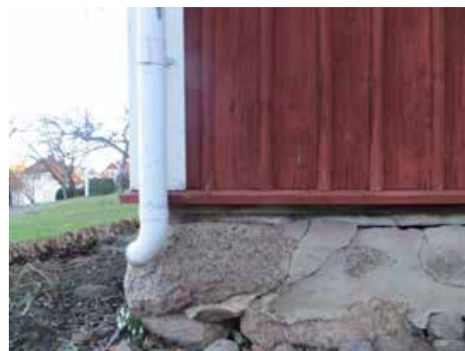
Detalj av sockeln och fasadpanelen.
