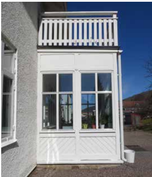
Glasverandan är bevarad, men hårt renoverad.
