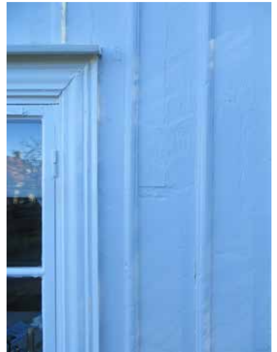
Ovan: Detalj av den handhyvlade, kilsågade panelen där de bakre brädorna har varierande bredd. Till vänster: Byggnadens södra gavel.
