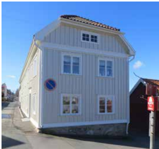
Ovan: Byggnadens gavel mot norr. Till höger: Byggnaden sedd från sydost.
