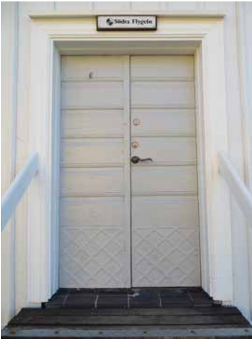
Ovan: Entrédörren är ursprunglig. Till höger: Flygelbyggnaden sedd från sydväst.
