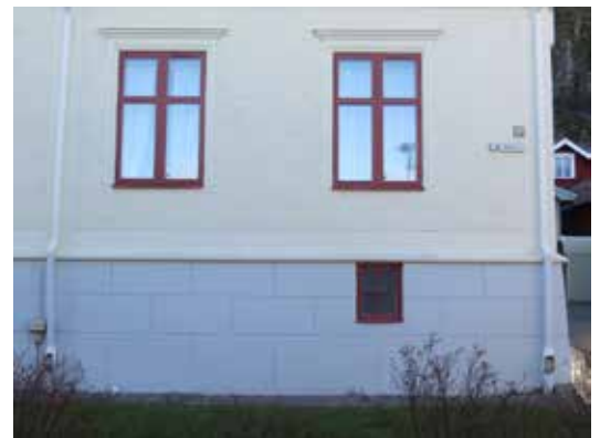
Parti av den västra fasaden mot gatan.
