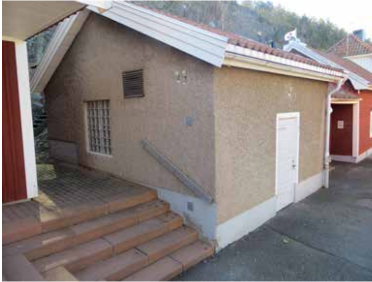
Pannhuset sett från nordväst.
