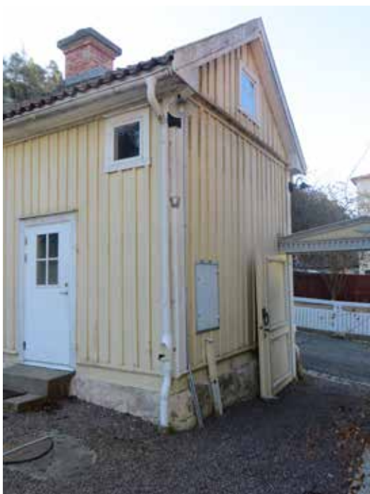
Ovan Den västra gaveln. Nedan: Det västra gavelröstets fönster är särskilt ålderdomligt med vinkelbeslag som torde vara från 1800-talets mitt eller tidigare.
