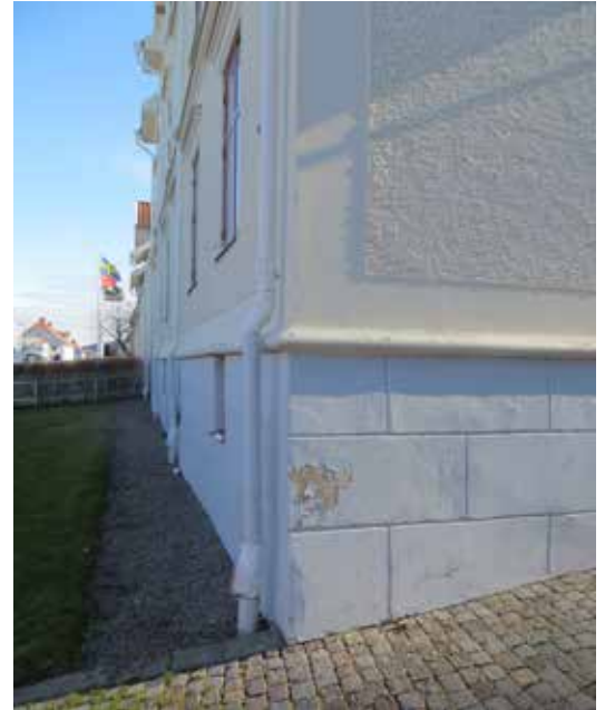
Ovan: Detalj av fasaden med slätputs, spritputs och kvadernmönstrad sockel.
