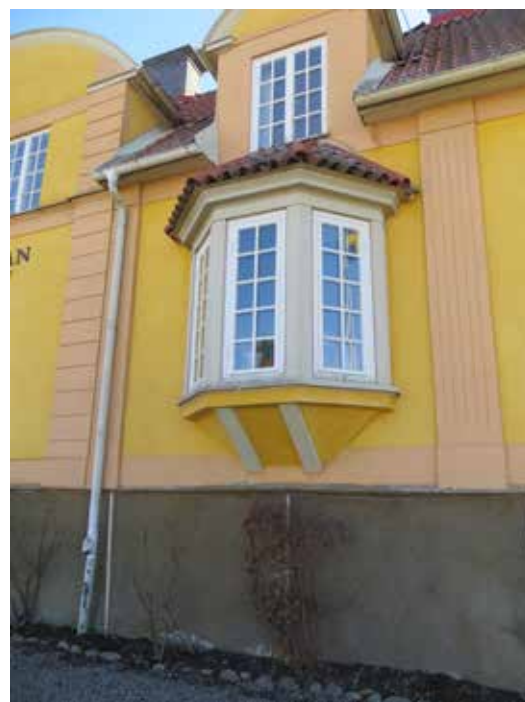
Den västra fasadens burspråk som tillkom på 1910-talet.
