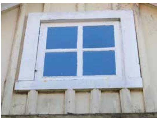
Ovan Den västra gaveln. Nedan: Det västra gavelröstets fönster är särskilt ålderdomligt med vinkelbeslag som torde vara från 1800-talets mitt eller tidigare.
