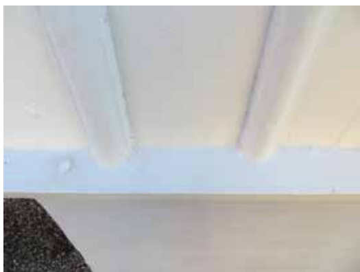
Detalj av fasaden med handhyvlat och kilsågad panel.
