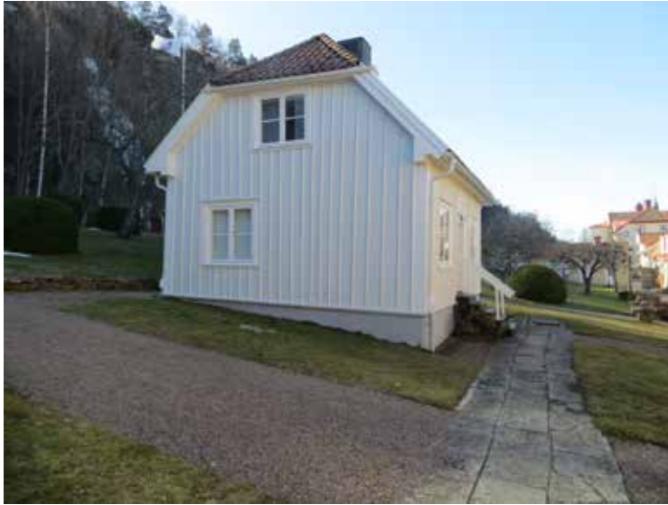
Den södra flygelns norra fasad.
